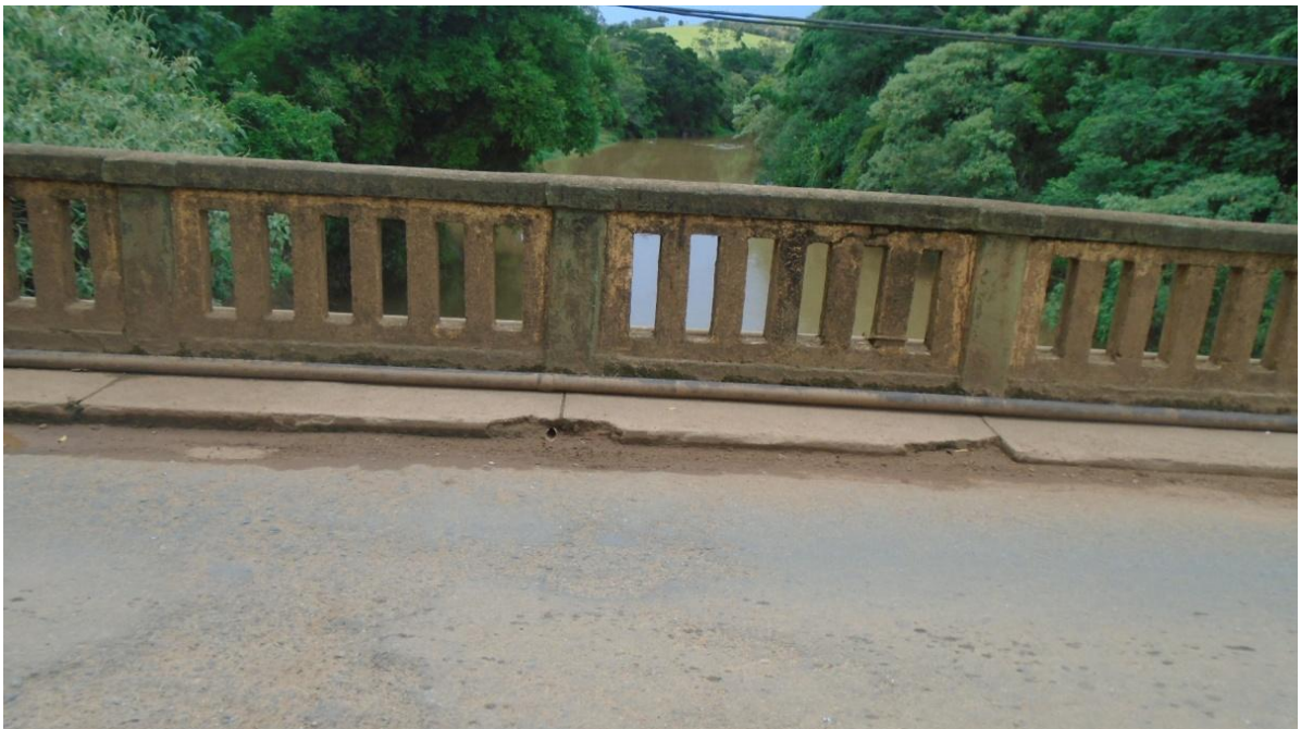
Foto 6 – Abertura para escoamento da vazão da água pluvial (lado nº 02)
