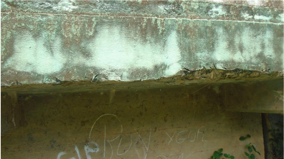
Foto 7 – Início de recuperação de ferragem exposta
