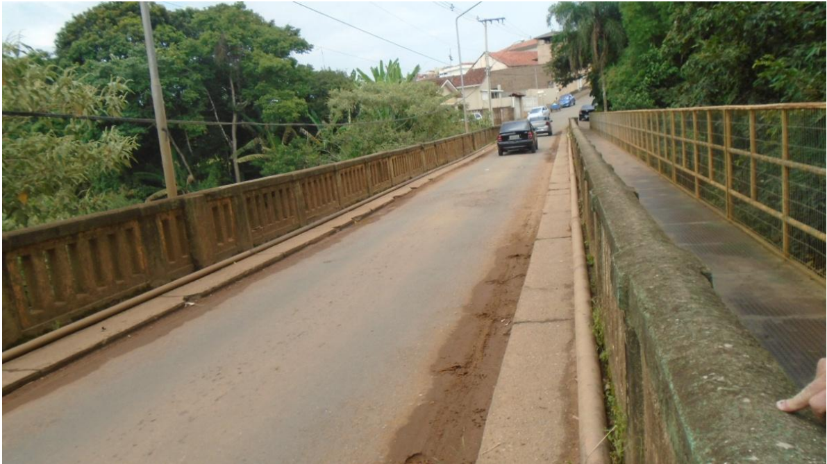
Foto 3 – Lado nº 01 da ponte
