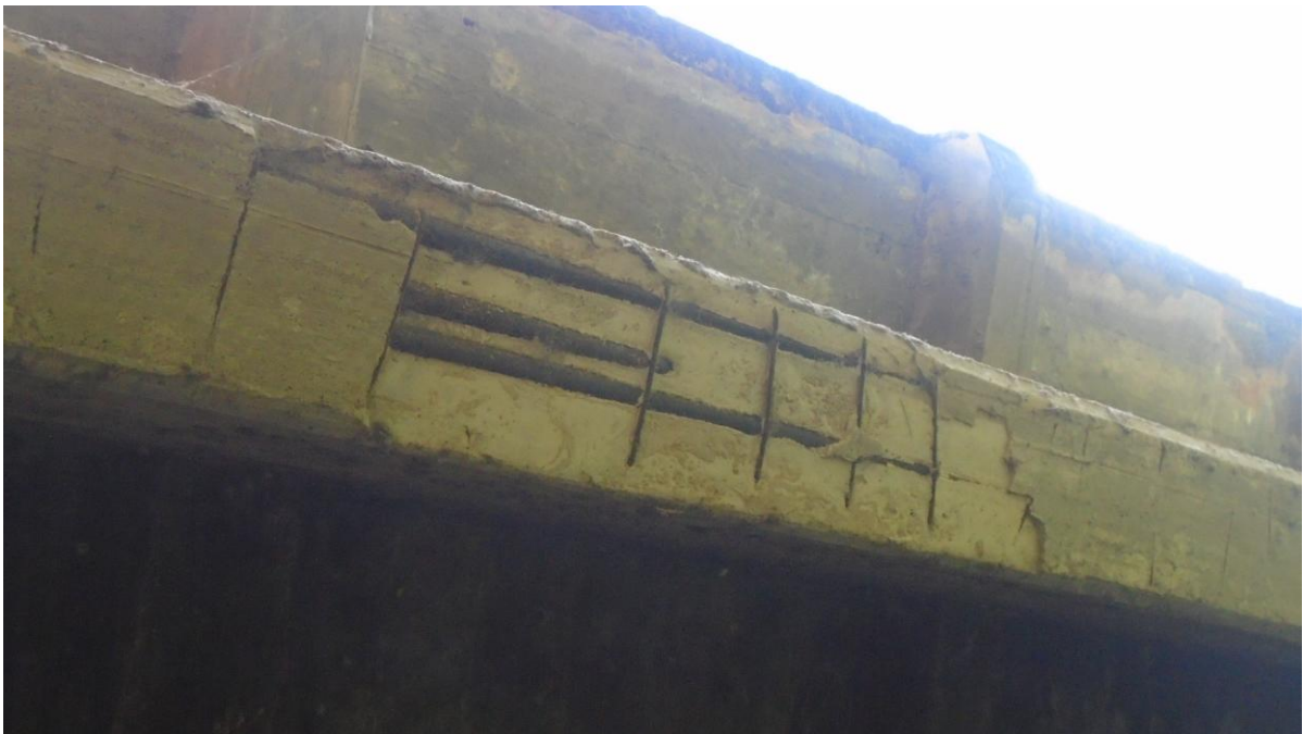
Foto 10 – Ferragem exposta
