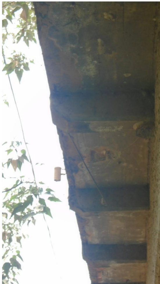
Foto 12 – Ferragem solta
