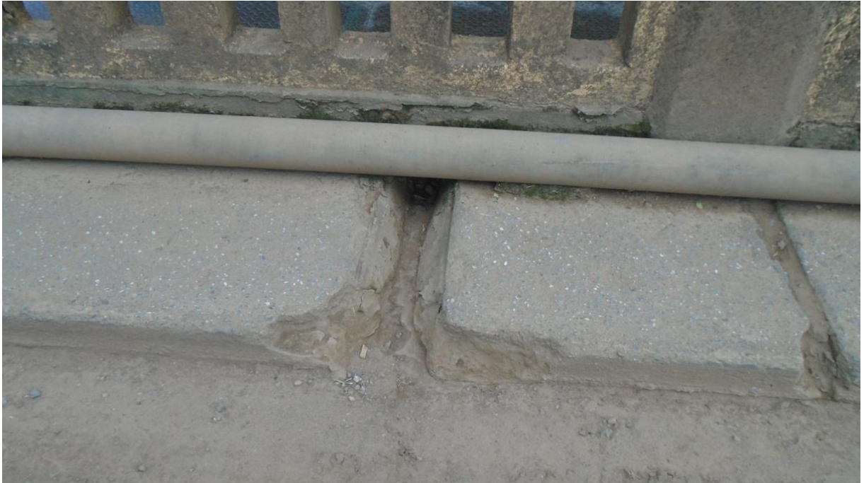
Foto 5 - Abertura para escoamento da vazão da água pluvial (lado nº 01)
