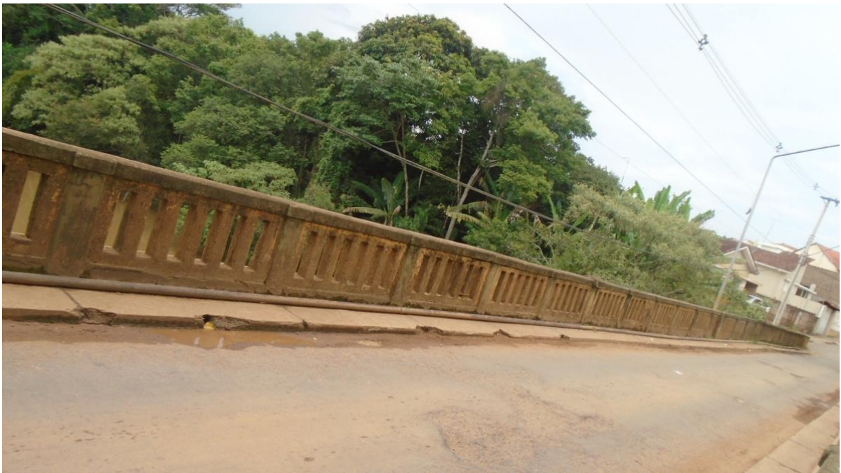
Foto 4 – Lado nº 02 da ponte
