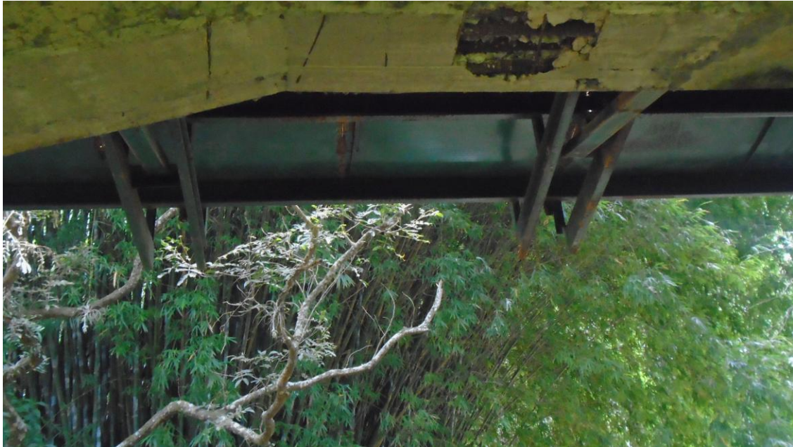
Foto 11 – Oxidação: Passarela/Ponte
