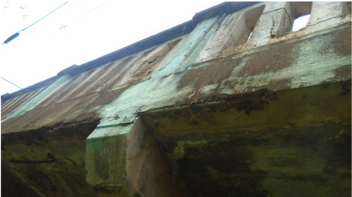
Foto 8 – Ferragem exposta
